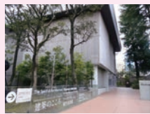
▲国立近現代建築資料館
